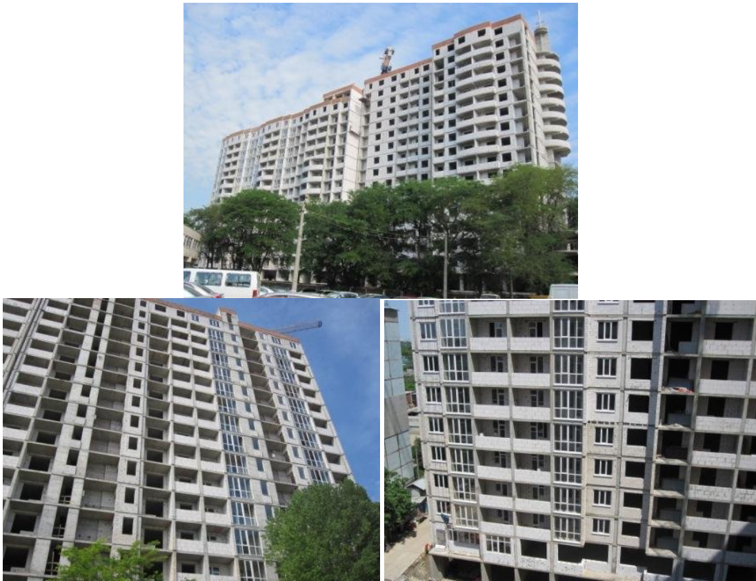
Рисунок 1. Будівництво житлового будинку по вул. Ак. Корольова, 5/2 у м. Одесі станом на 08.06.2010 року
