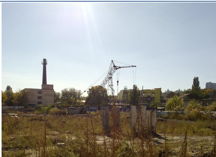
Хід робіт на об'єкті будівництва по вул. Мандриківській, 43 у м. Дніпропетровську станом на кінець вересня 2010 року
