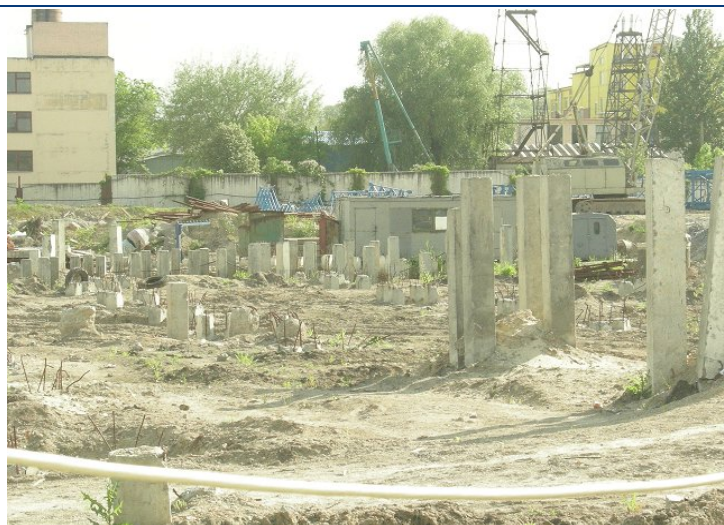
Хід робіт на об'єкті будівництва по вул. Мандриківській, 43 у м. Дніпропетровську станом на 13.05.2010 р.
