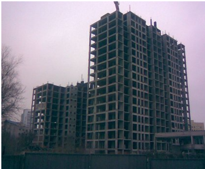
Хід робіт на об'єкті будівництва по пров. Ламаному в м. Дніпропетровську станом на 01.03.2010 р.
