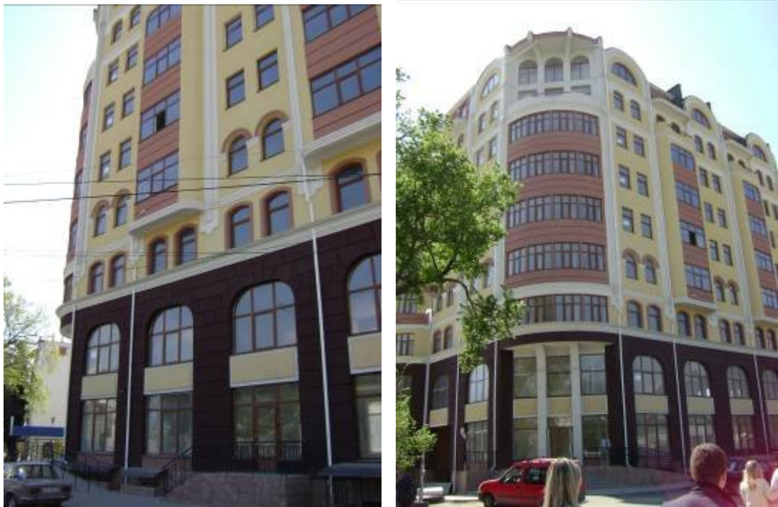
Готельний комплекс з офісними приміщеннями, апартаментами та магазином по вул. Баглікова в м. Алушті.
