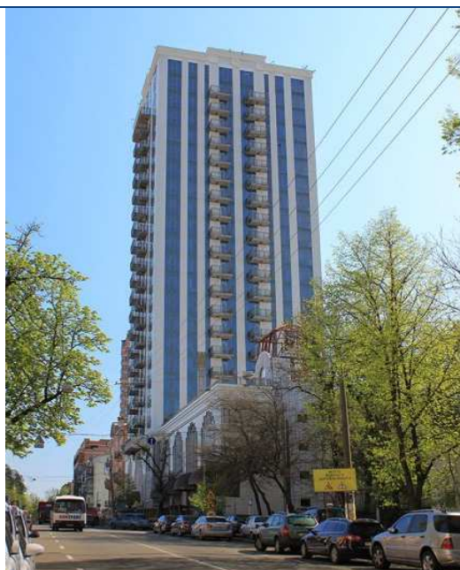
Хід будівництва житлово-офісного комплексу по вул. Воровського, 21 у м. Києві станом на початок травня 2015 року
