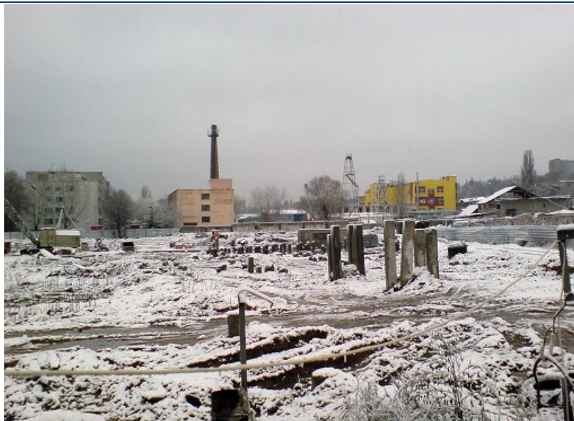
Хід робіт на об'єкті будівництва по вул. Мандриківській, 43 у м. Дніпропетровську станом на 07.12.2009 р.
