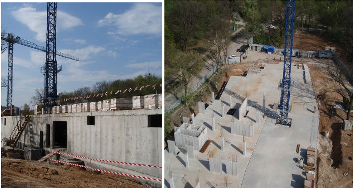
Стан будівництва житлового комплексу по вул. Фронтоній, 3 у м. Харкові станом на 30.04.2009 р.
