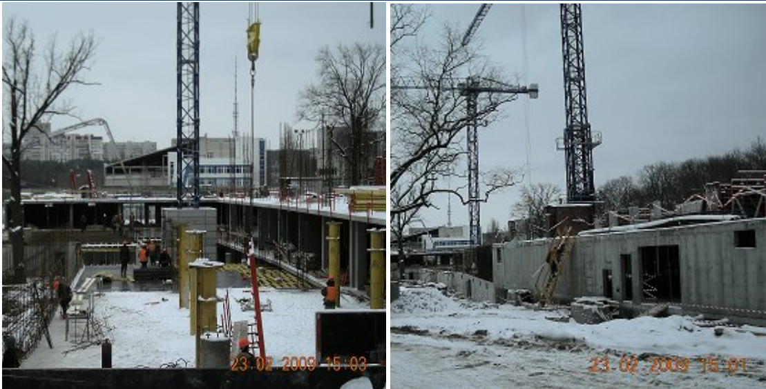
Стан будівництва житлового комплексу по вул. Фронтоній, 3 у м. Харкові станом на 23.02.2009 р.
