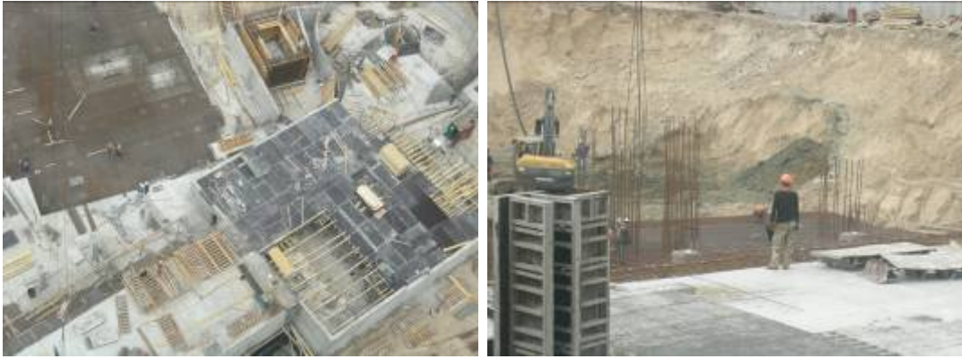
Рисунок 1.5. Хід будівництва житлового комплексу «Парк Авеню» (II- IV черги) станом на 20.05.2009 р.
