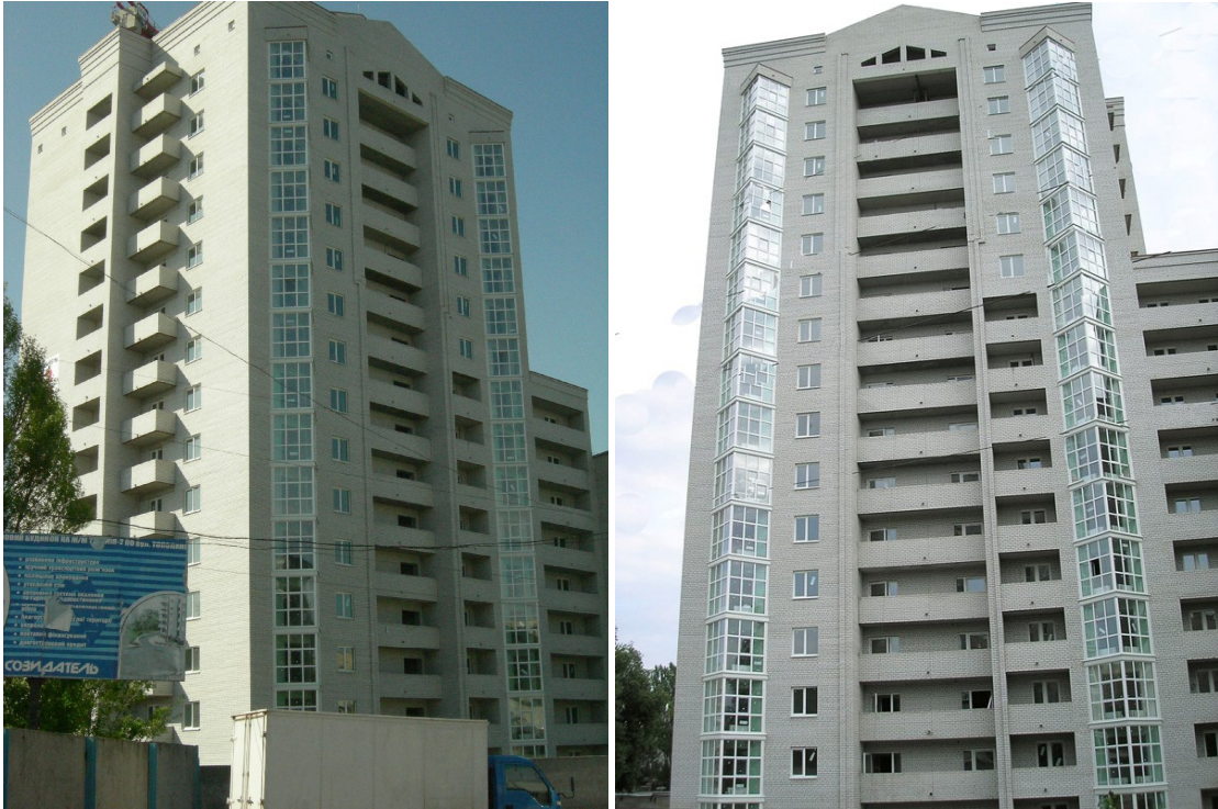
Об'єкт по вул. Тополиній, 7, м. Дніпропетровськ станом на травень 2010 року та вересень 2010 року
