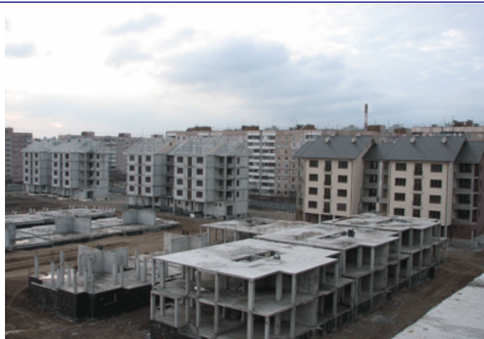
Хід будівництва житлового будинку № 4-5 по вул. Медичній, станом на 13.02.2009 р.
