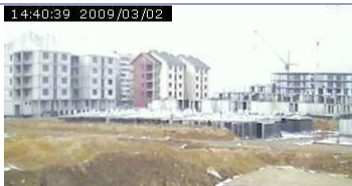
Хід будівництва житлових будинків №№ 6-9, 7-9 по вул. Медичній, станом на 02.03.2009 р.
