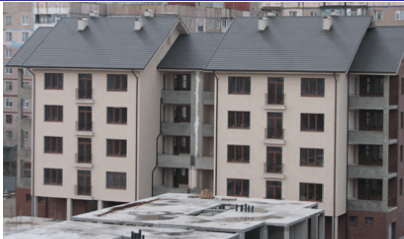
Хід будівництва житлового будинку № 3 по вул. Медичній, станом на 13.02.2009 р.
