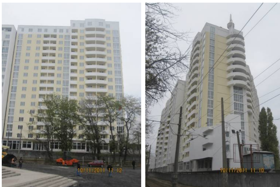
Рисунок 1. Будівництво житлового будинку по вул. Ак. Корольова, 5/2 у м. Одесі станом на 10.11.2011 р.
