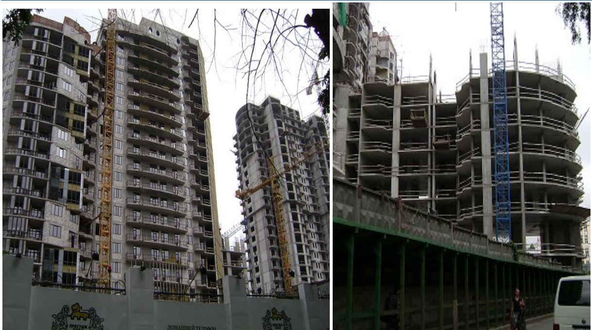
Будівництво житлово-офісного комплексу з вбудованими, прибудованими приміщеннями та підземним паркінгом по вул. Анрі Барбюса, 37/1 у Печерському районі м. Києва станом на 24.06.2010 р.
