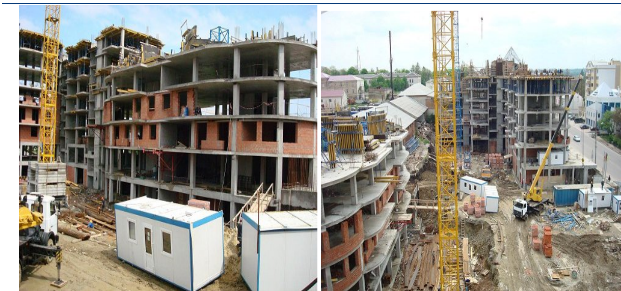
Хід будівництва групи багатоквартирних житлових будинків по вул. Червоноармійській, 43в у м. Чернівцях станом на 10.06.2008 р.
