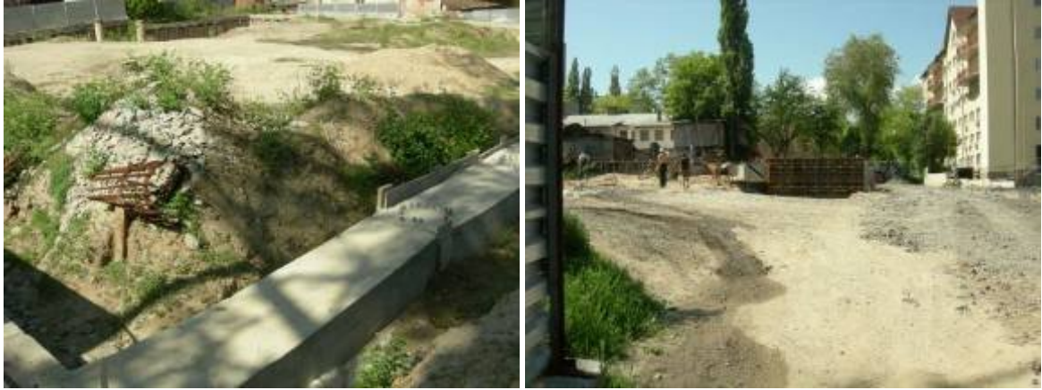
Об'єкт будівництва по вул. Шевченка у м. Дніпропетровську, II півріччя 2010 року
