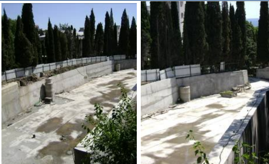
Стан будівництва за проектом реконструкції кінотеатру з добудовою рекреаційно-оздоровчого корпусу за адресою: АР Крим, смт. Гурзуф, вул. Ленінградська, 1 А станом на кінець серпня 2009 року
