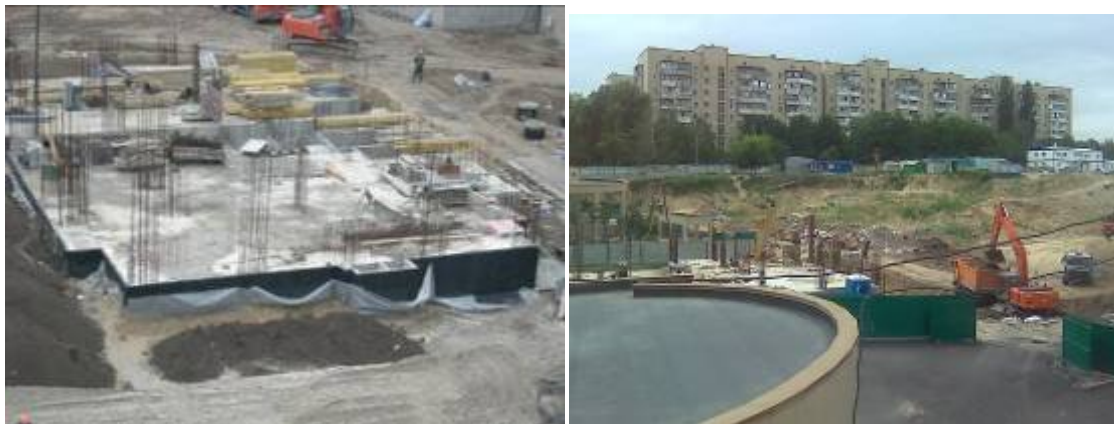
Хід будівництва житлового комплексу «Парк Авеню» (II- IX черги) станом на 03.12.2009 р. та станом на кінець червня 2010 р.
