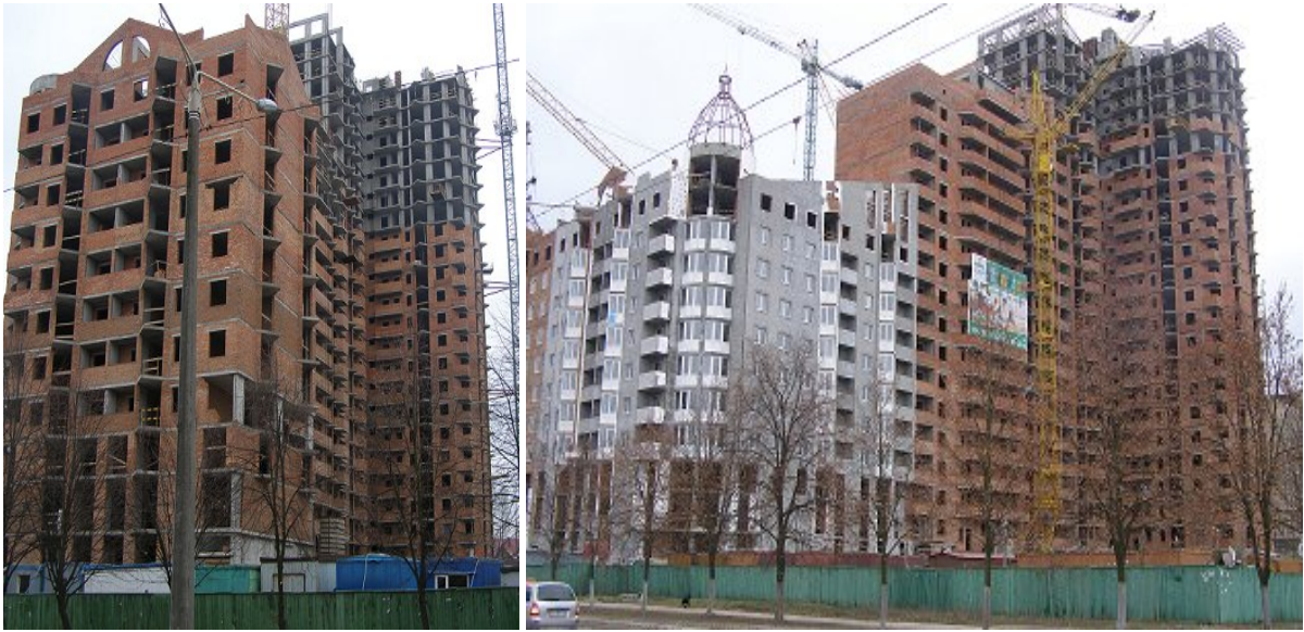
Хід виконання будівельних робіт житлового мікрорайону по просп. Шевченка, 2 (зліва-направо: I та II черги) у м. Вишгороді станом на початок лютого 2009 року
