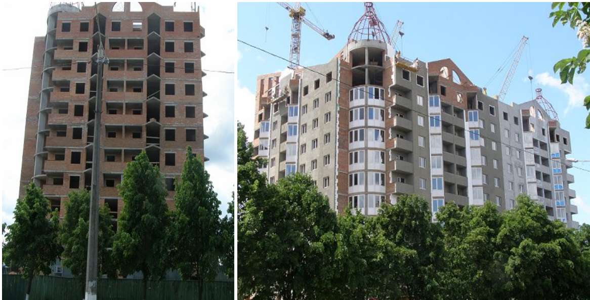
Хід виконання будівельних робіт житлового мікрорайону по просп. Шевченка, 2 (зліва-направо: I та II черги) у м. Вишгороді станом на 15.05.2009 року
