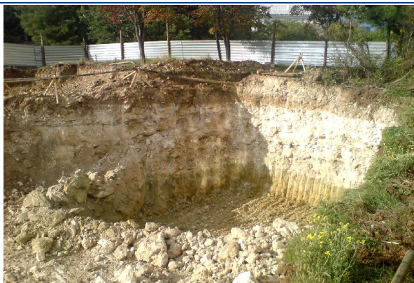
Хід робіт на об'єкті будівництва по пр. Гагаріна, 48 у м. Севастополі станом на 10.10.2008 р.
