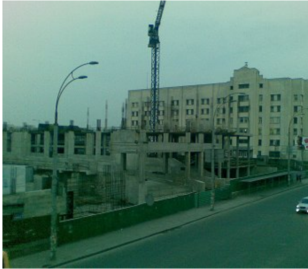
Стан будівництва офісної будівлі за адресою: м. Київ, пров. Індустріальний, 1-А на 15.11.2010 р.
