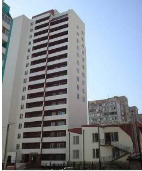
Об'єкт будівництва - житловий будинок № 30 у мікрорайоні III-4-2 Котовського у м. Одесі
