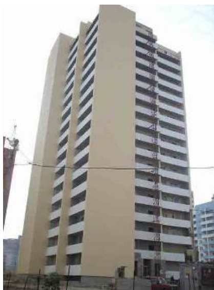
Об'єкт будівництва - житловий будинок № 29 у мікрорайоні III-4-2 Котовського у м. Одесі
