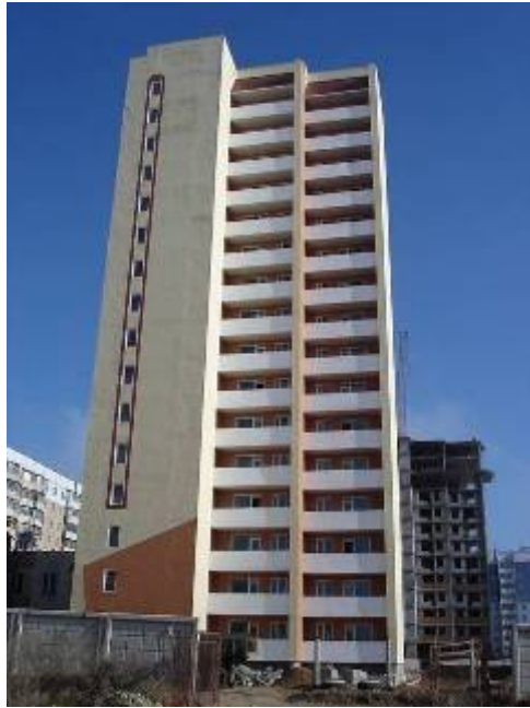
Об'єкт будівництва - житловий будинок № 28 у мікрорайоні III-4-2 Котовського у м. Одесі.
