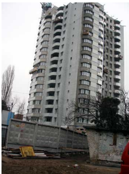
Рисунок 1. Будівництво житлового будинку по бул. Я. Гашека, 8а станом на 09.09.2009 р.
