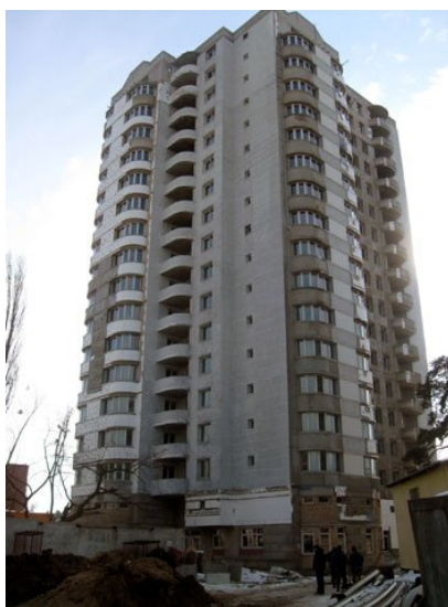
Рисунок 2. Будівництво житлового будинку по бул. Я. Гашека, 8а станом на кінець лютого 2010 р.
