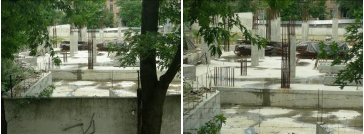
Хід робіт з будівництва багатоповерхового житлового будинку з вбудовано-прибудованими приміщеннями громадського призначення та підземного паркінгу по вул. Білоруській, 36-а у Шевченківському районі м. Києва станом на кінець вересня 2009 року
