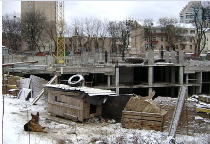
Хід робіт з будівництва багатоповерхового житлового будинку з вбудовано-прибудованими приміщеннями громадського призначення та підземного паркінгу по вул. Білоруській, 36-а у Шевченківському районі м. Києва станом на 10.12.2010 р.
