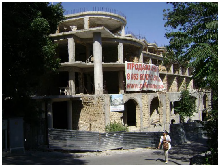
Стан будівництва рекреаційного комплексу по вул. Дворцове шосе, 3 у м. Алупці станом на 21.08.2009 р.
