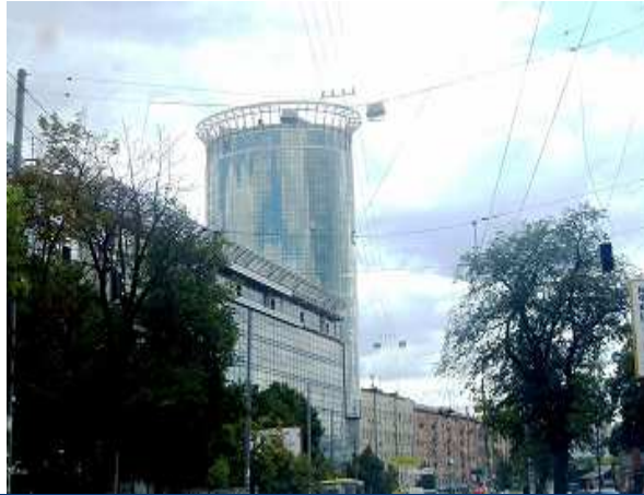
Об'єкт незавершеного будівництва по вул. Мельникова, 2/10, станом на кінець червня 2014 року
