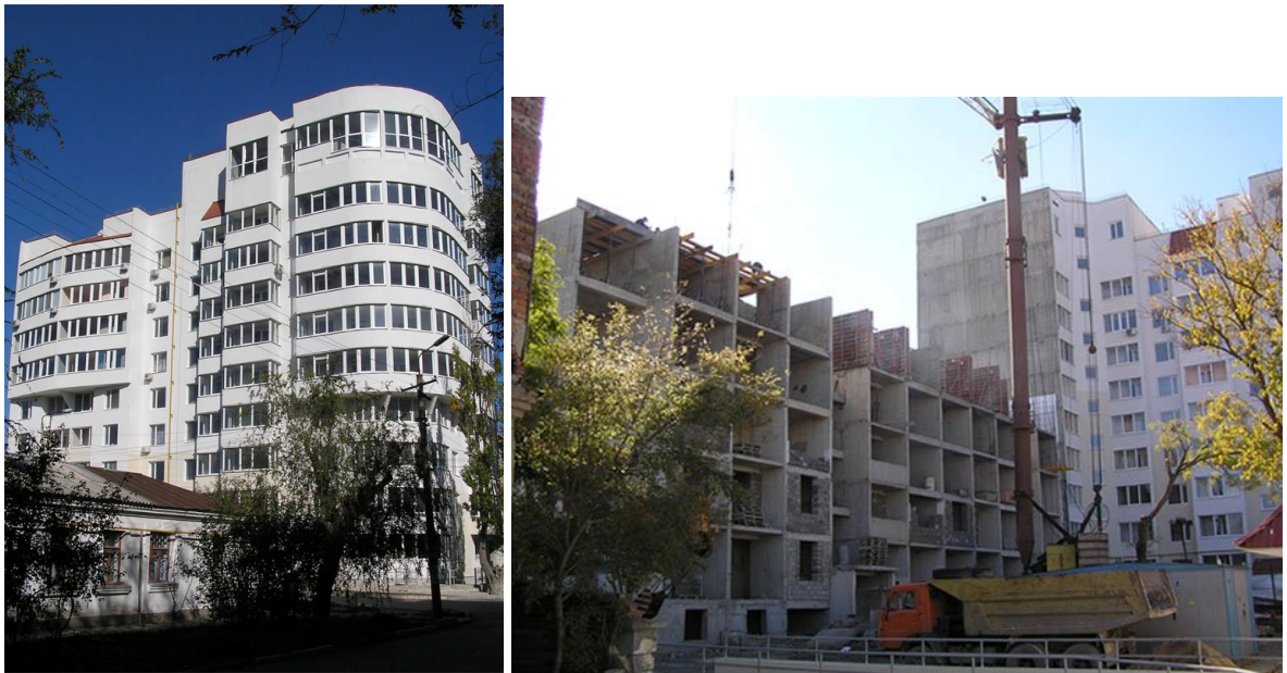
Рисунок 2. Будівельні роботи по вул. Вересаєва, 12 у м. Феодосії станом на листопад 2010 року
