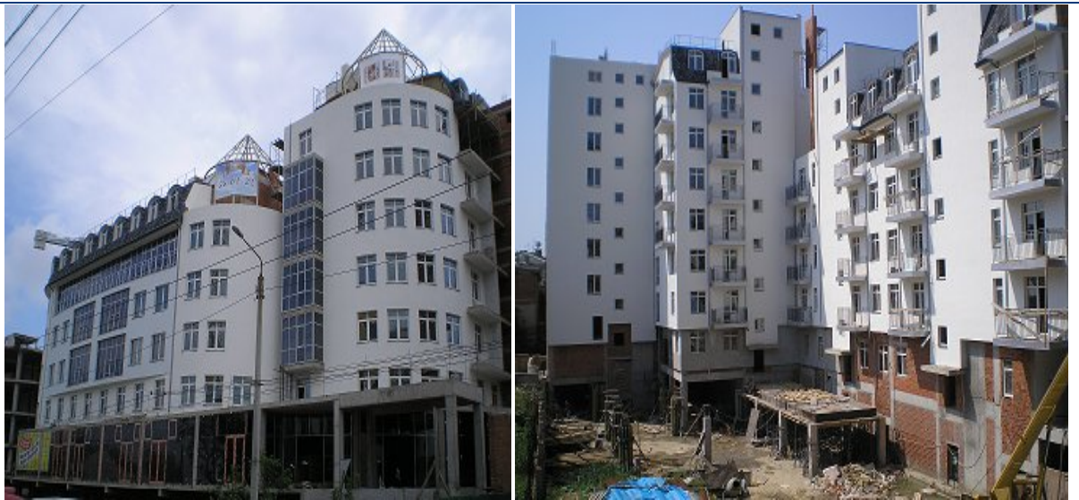
Хід будівництва групи багатоквартирних житлових будинків по вул. Червоноармійській, 43 В у м. Чернівцях станом на 09.08.2010 р.
