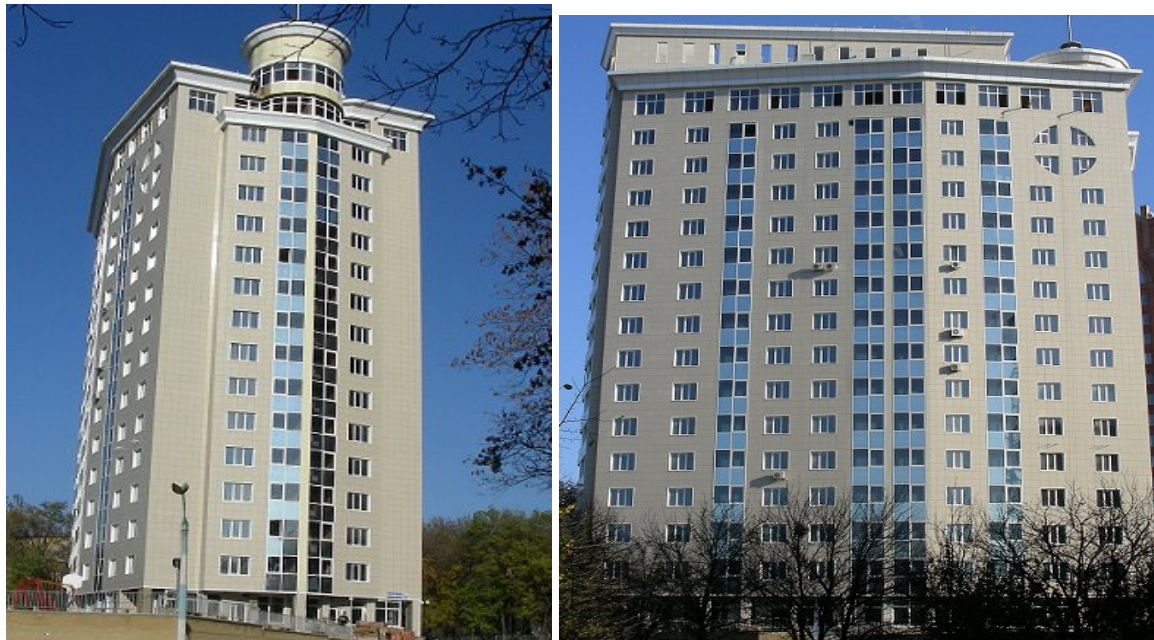
Об'єкт будівництва по пр. Панфілова
