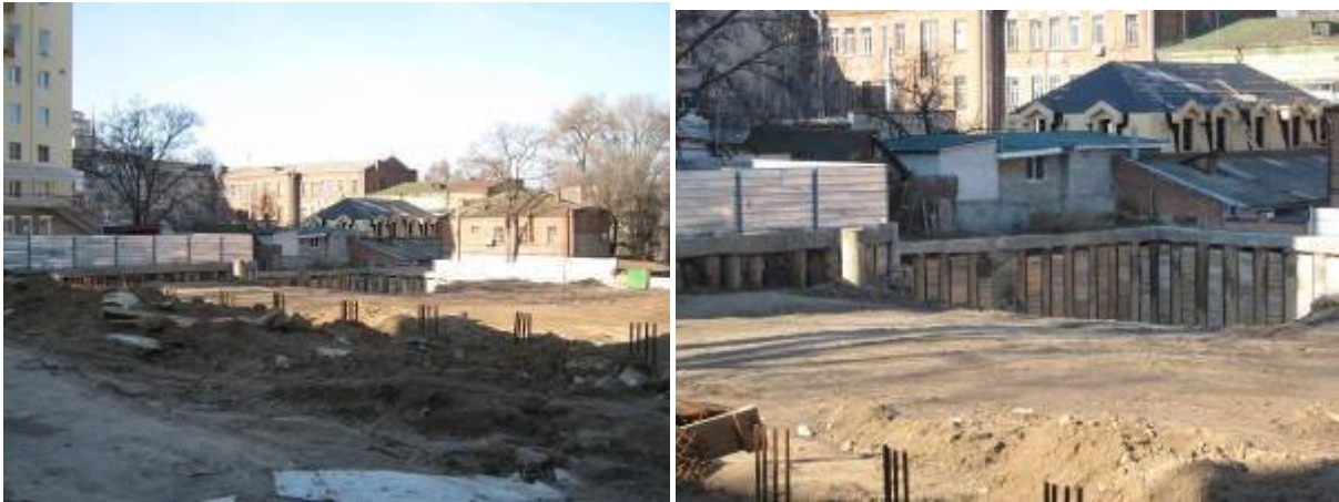
Рисунок 1. Хід робіт на об'єкті будівництва по вул. Шевченка у м. Дніпропетровську в 2009 році
