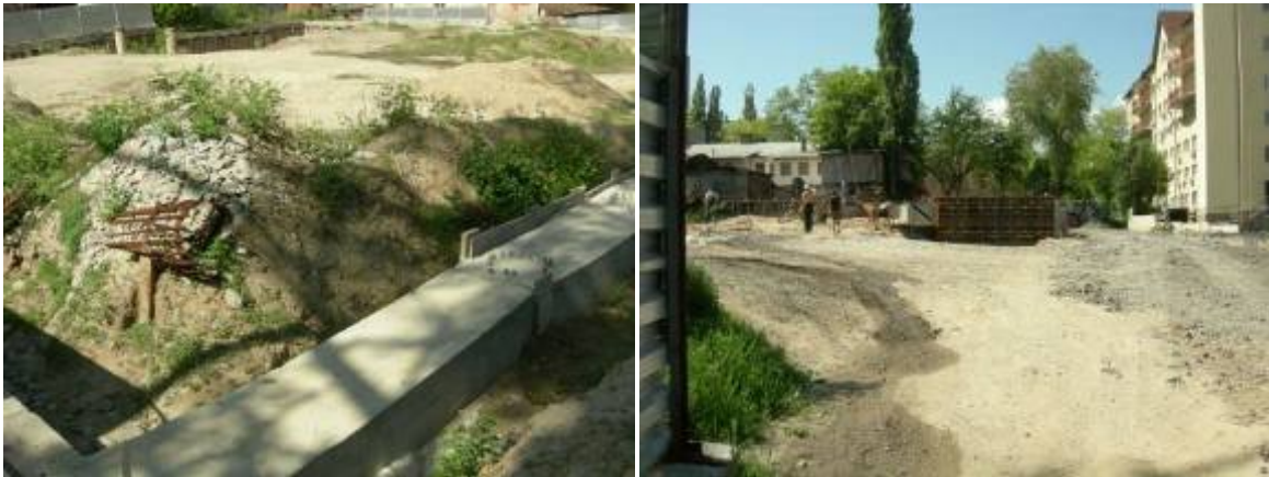
Рисунок 2. Хід робіт на об'єкті будівництва по вул. Шевченка у м. Дніпропетровську в 2010 році
