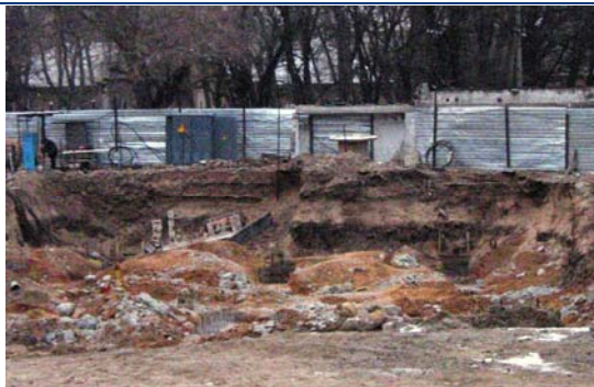
Рисунок 2.3. Хід робіт на об'єкті будівництва по вул. Станіславського, 3 у м. Дніпропетровську станом на 14.02.2008 р.
