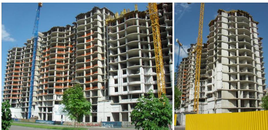
Рисунок 2.2. Будівельні роботи по вул. Бородинській – пров. Зірковому станом на середину травня 2009 року
