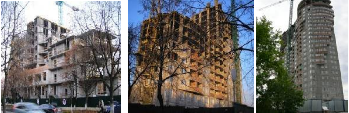
Хід робіт на об'єкті будівництва по вул. П. Запорозця, 26-А станом на (зліва - направо) початок листопада 2007 року, початок лютого 2008 року, початок травня 2008 року
