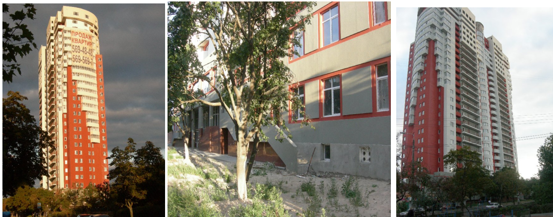
Об'єкт будівництва по вул. П. Запорозця, 26-А станом на вересень 2009 року
