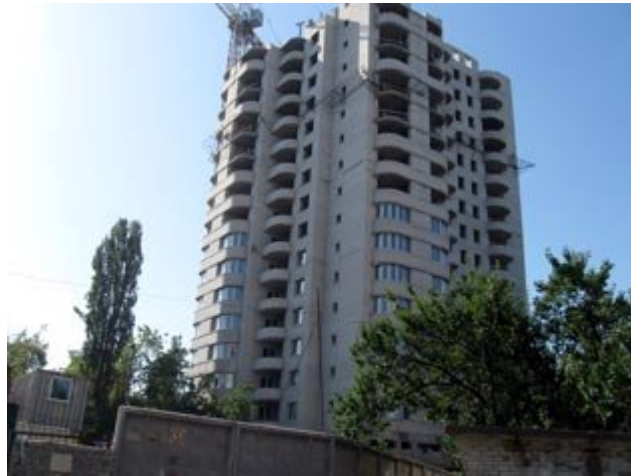
Рисунок 1. Будівництво житлового будинку по бул. Я. Гашека, 8а станом на 09.09.2009 р.
