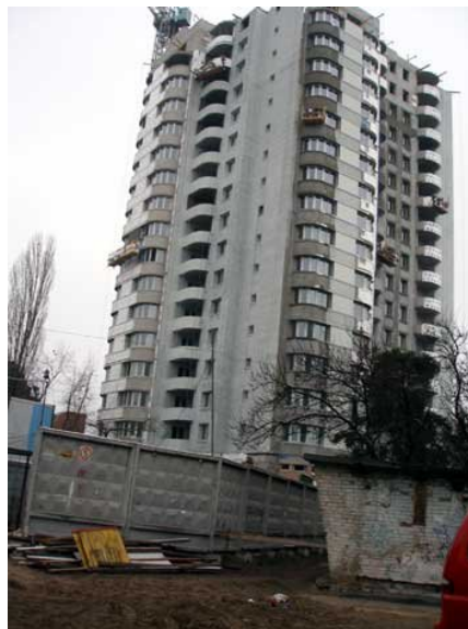
Рисунок 2. Будівництво житлового будинку по бул. Я. Гашека, 8а станом на листопад 2009 р.
