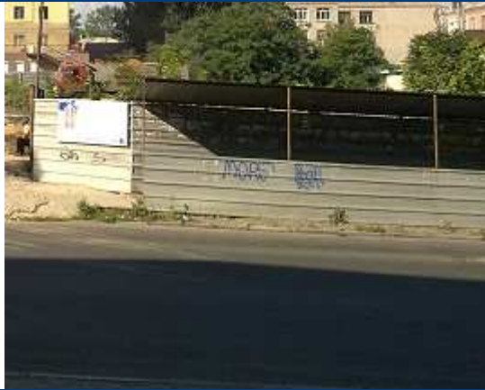
Об'єкт незавершеного будівництва по вул. Шевченка у м. Дніпропетровську станом на кінець червня 2013 року
