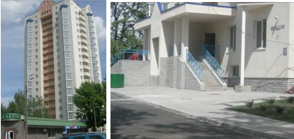
Рисунок 4. Об'єкт по проспекту газети «Правда» в районі будинку №16, м. Дніпропетровськ станом на кінець травня 2009 року
