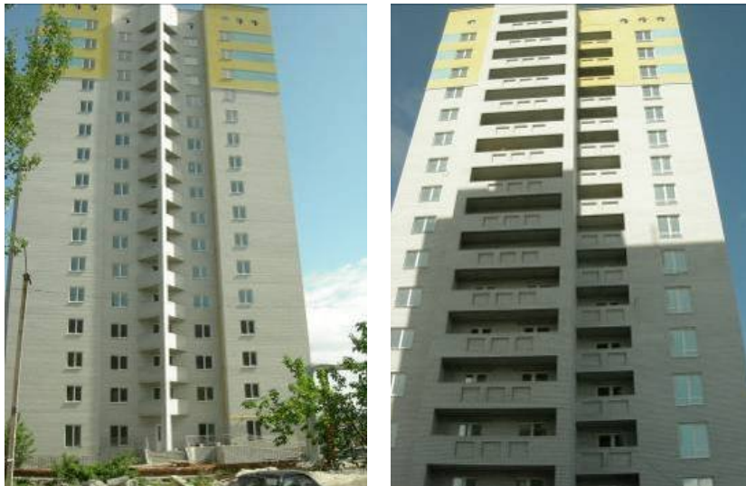
Рисунок 2. Об'єкт будівництва в районі вулиць Космічної та Мандриківської, м. Дніпропетровськ (друга черги) станом на травень 2010 року
