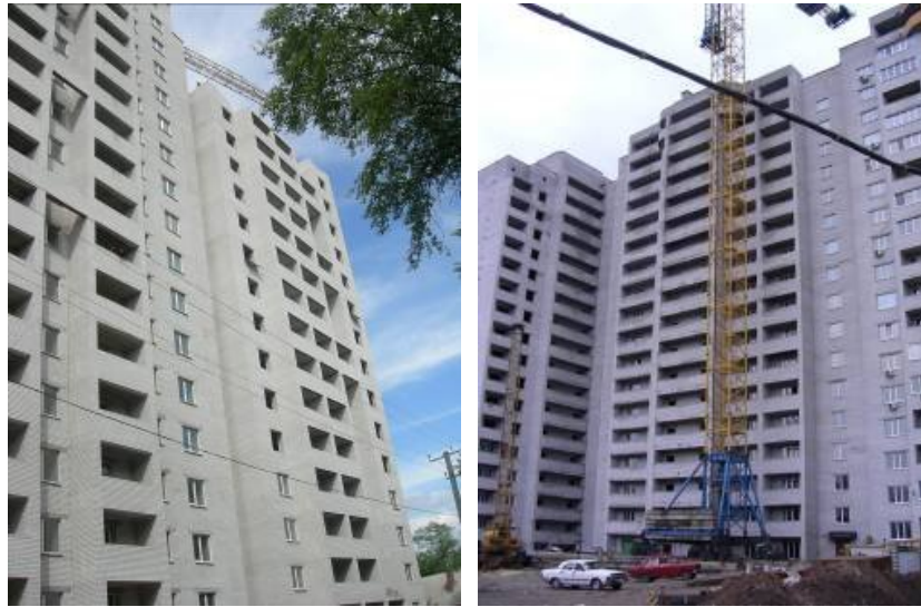
Рисунок 5. Об'єкт по вул. Дмитра Кедріна, в районі будинку №55 (III черга), м. Дніпропетровськ станом на кінець травня 2009 року та на грудень 2009 року.
