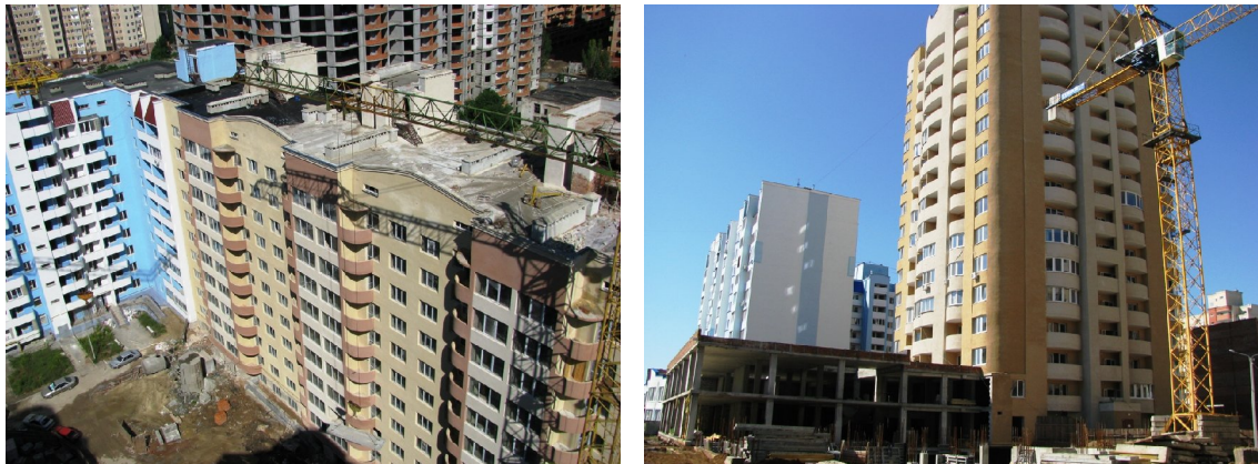
Рисунок 4. Стан будівництва громадсько-житлового комплексу по вул. М. Говорова, 10 А у м. Одесі на 18.06.2010 р.
