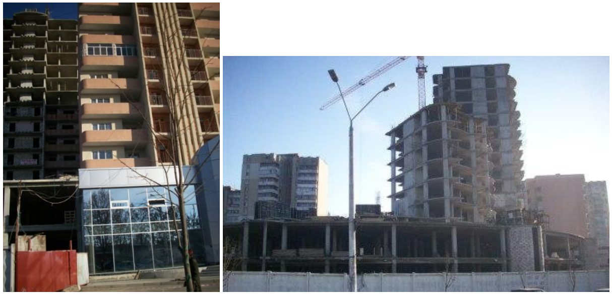
Рисунок 1. Стан будівництва громадсько-житлового комплексу у мікрорайоні ім. Таїрова на розі вул. 25-ї Чапаївської дивізії та просп. Маршала Жукова у м. Одесі на початок 2010 р.
