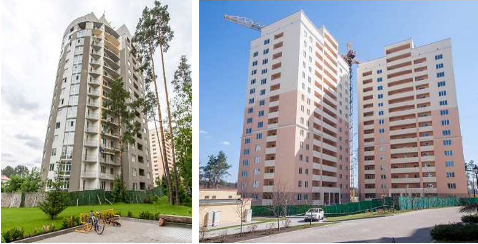
Будівництво житлового комплексу (II черга) по вул. Лобановського, 1 у с. Чайці Києво-Святошинського району Київської області станом на кінець травня 2013 року (зліва направо: будинок №8, будинок №9)
