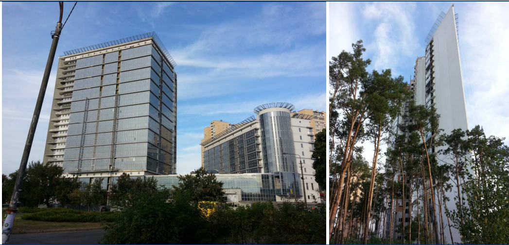
Хід будівництва об'єкту «Артеміда комплекс» на перехресті Дарницького бульвару та вул. Генерала Жмаченка у м. Києві станом на кінець вересня 2014 року
