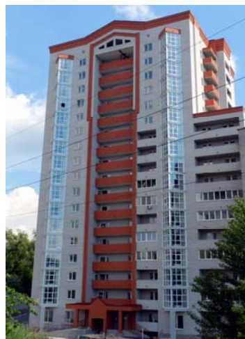
Житловий комплекс по вул. Тополиній, 7, м. Дніпропетровськ
