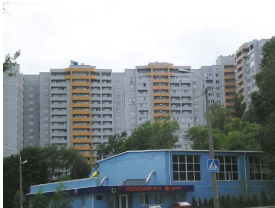
Об'єкт по вул. Дмитра Кедріна, в районі будинку №55 (III черга), м. Дніпропетровськ станом на кінець вересня 2010 року
