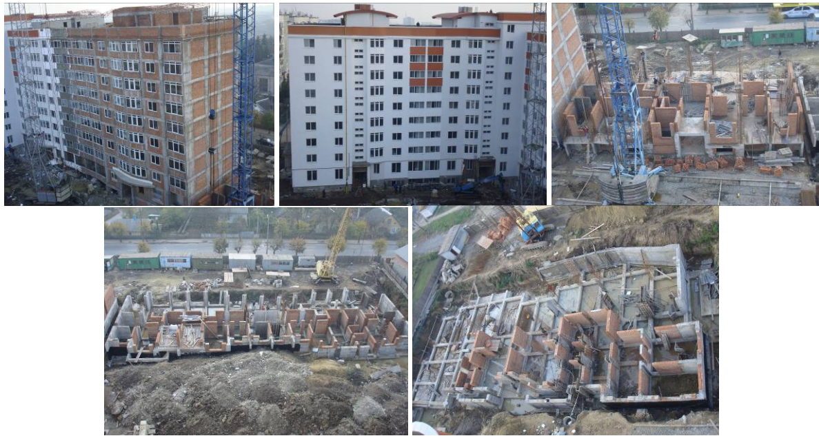
Будівництво житлового комплексу у м. Чернівцях по вул. Руській, 219 (зверху зліва-направо будинки №№ 5, 6 та 4; знизу зліва-направо фундаменти будинків №№ 3 та 2) станом на кінець 2008 року
