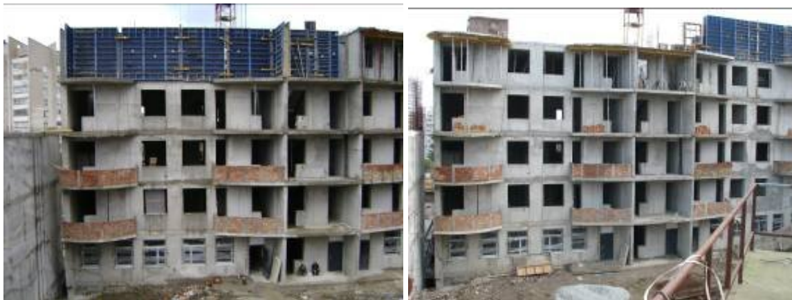
Рисунок 1.4. Стан будівництва житлового комплексу, який складається з житлових будинків (блок «Б1», блок «Б2», блок «Г») та підземних автостоянок (блок «А», блок «В») по вул. Жовтневій в районі житлового будинку №32 у м. Алушті станом на 22.11.2008 р. та станом на 20.02.2009 р.
