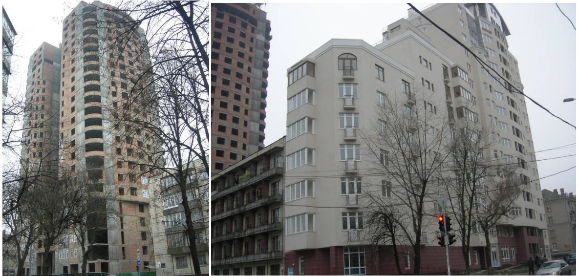
Рисунок 2. Стан будівництва житлових будинків №№ 1, 2, 4 по вул. М. Кривоноса та Климента на 01.12.2009 р.
