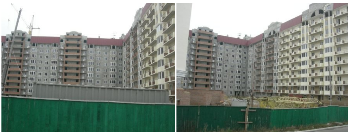
Рисунок 8. Будівництво житлового будинку у с. Чайці Київської області по вул. Коцюбинського, 9 (будівельний № 36) на 30.11.2009 р.
