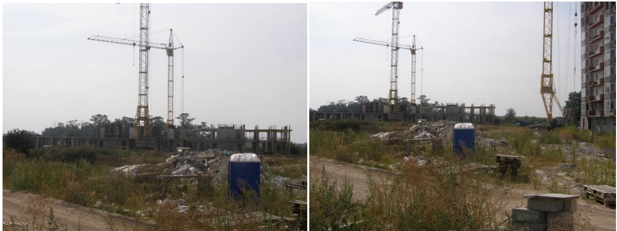
Рисунок 4. Стан будівництва житлових будинків у с. Чайці по вул. Коцюбинського, 29, 30 Київської області на 28.08.2009 р.
