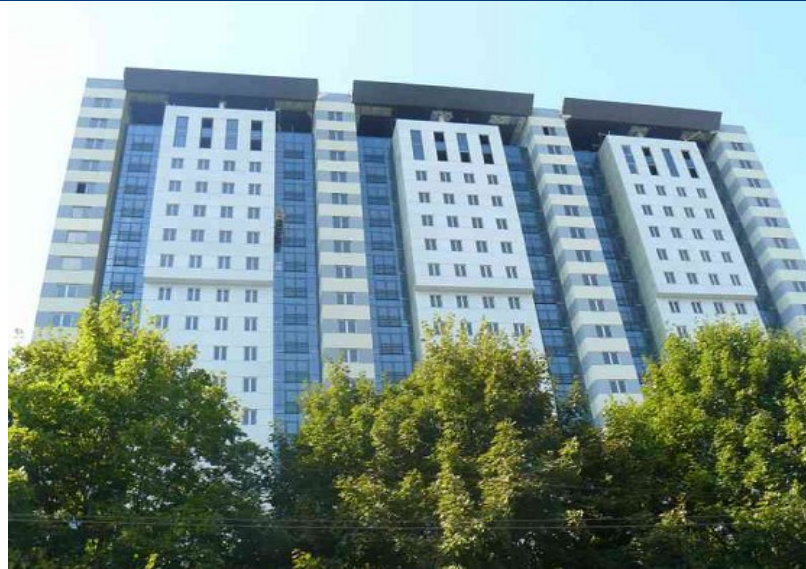
Житловий комплекс по вул. Ульянова, в районі буд. 17 А у м. Дніпропетровську
