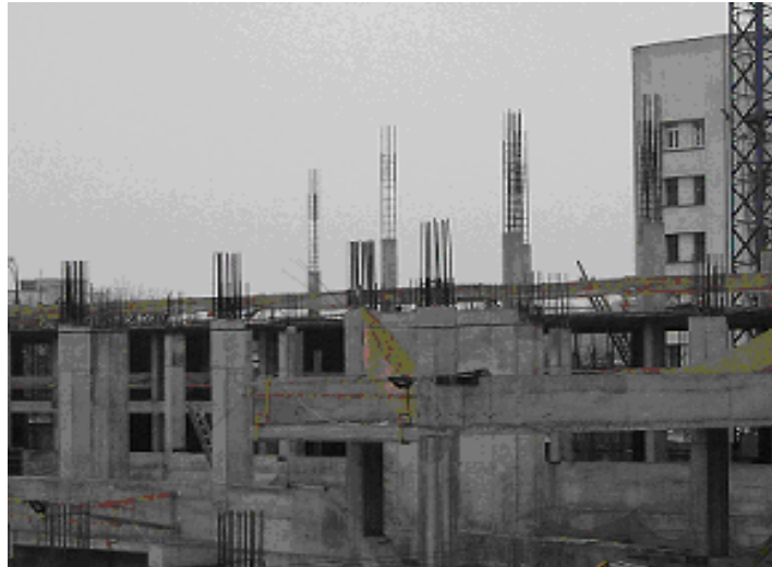
Стан будівництва офісної будівлі за адресою: м. Київ, пров. Індустріальний, 1-А на 26.02.2011 р.
