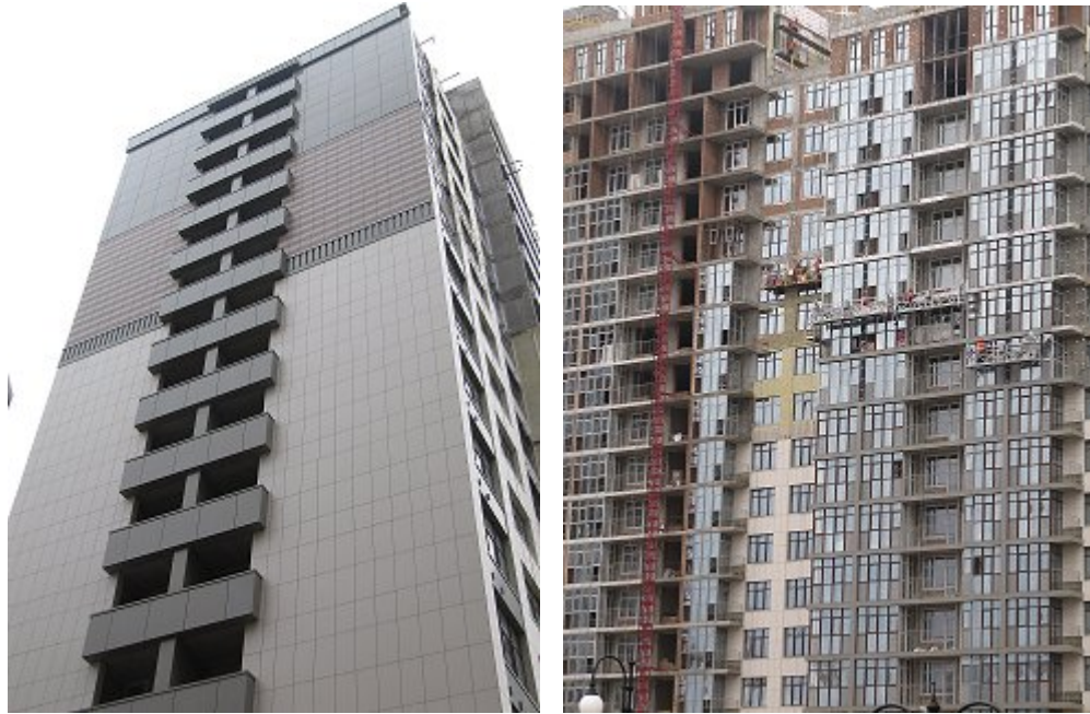
Хід будівництва другої черги житлового кварталу з об'єктами соціально-громадського призначення по вул. Професора Підвисоцького у Печерському районі м. Києва станом на початок січня 2012 року
