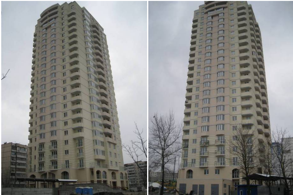
Будівництво житлового будинку у м. Києві на розі вулиці Героїв Дніпра та проспекту Героїв Сталінграду станом на 22.03.2009 р.
