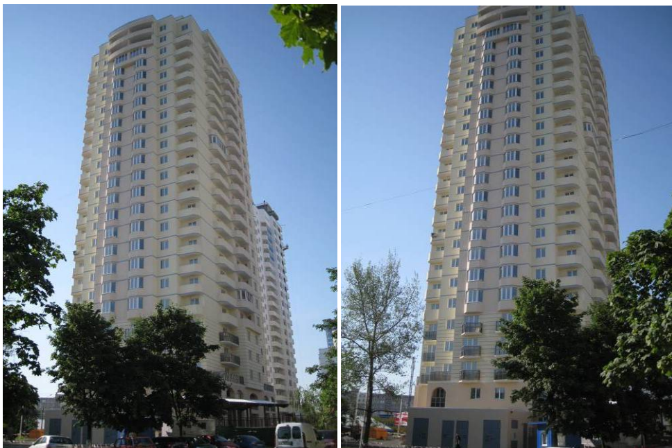
Будівництво житлового будинку у м. Києві на розі вулиці Героїв Дніпра та проспекту Героїв Сталінграду станом на 30.06.2009 р.
