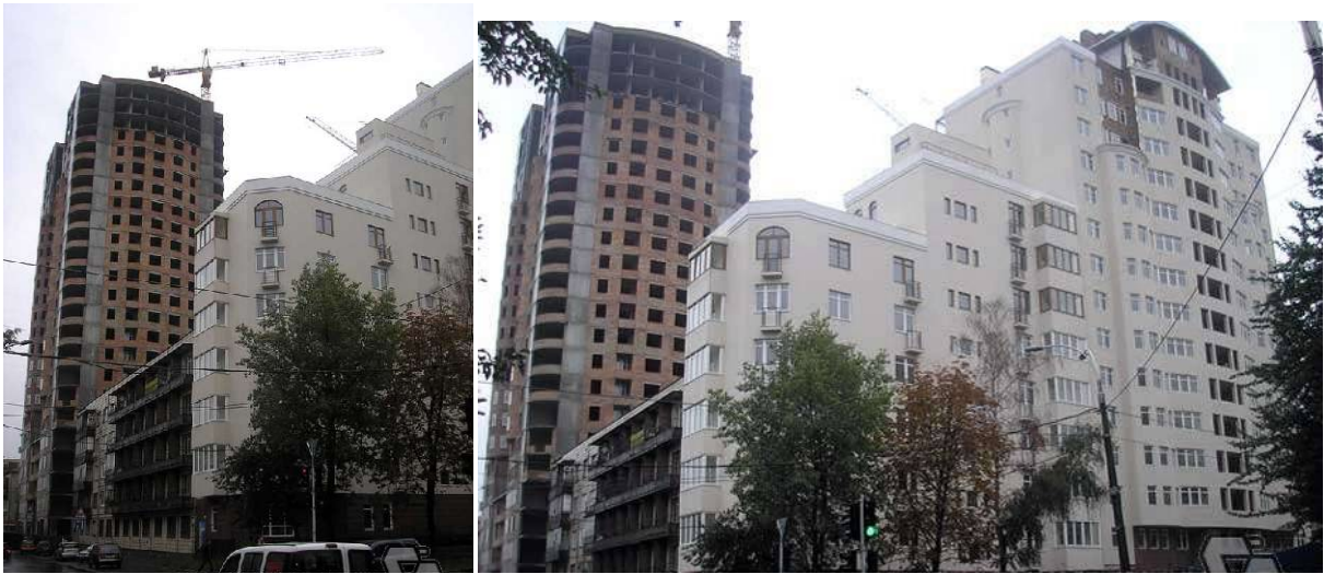
Стан будівництва житлових будинків по вул. М. Кривоноса та Клименка на початок жовтня 2008 року
