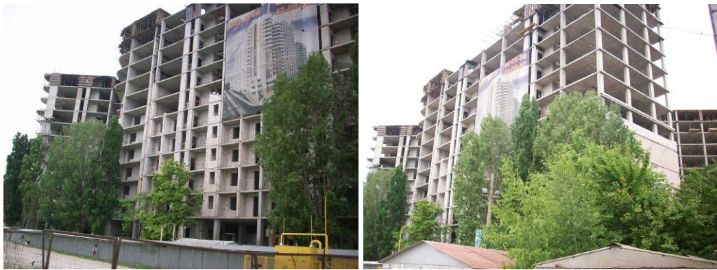
Будівництво житлового будинку по вул. Ак. Корольова, 5/2 у м. Одесі станом на кінець травня 2009 року
