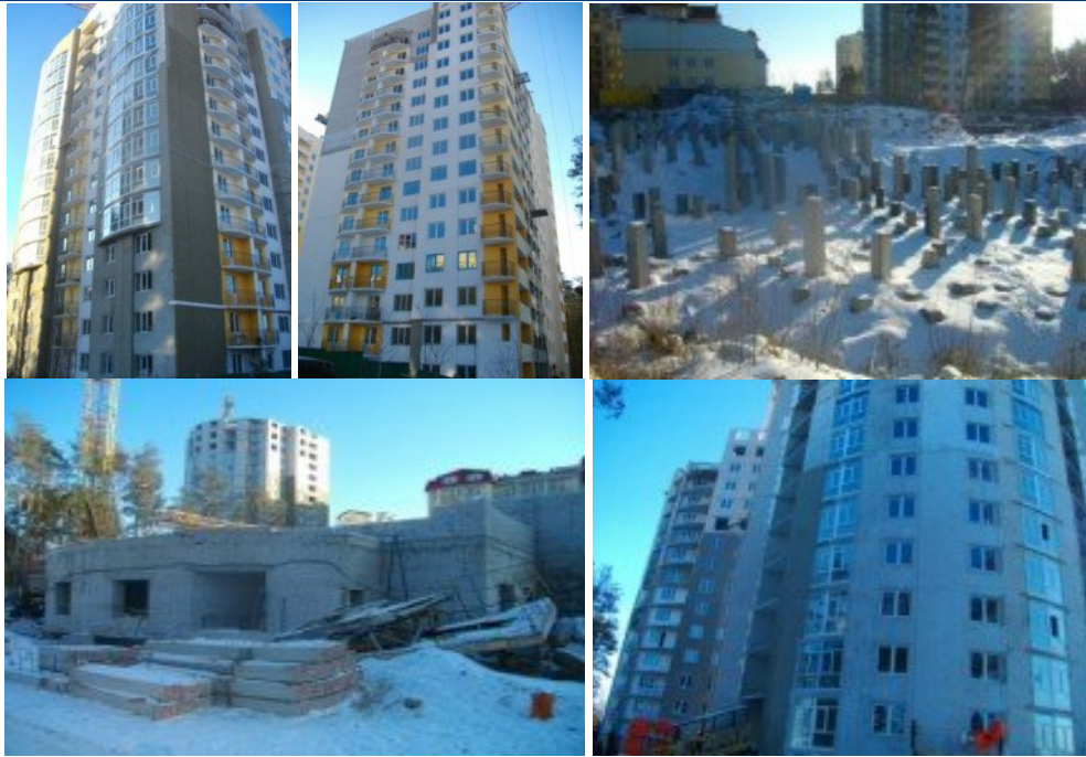
Рисунок Ошибка! Текст указанного стиля в документе отсутствует..4. Будівництво житлового комплексу (II черга) по вул. Лобановського, 1 у с. Чайці Києво-Святошинського району Київської області станом на лютий 2011 року: будинки № 6, 7, 8, 9 та 10 (зліва направо)
