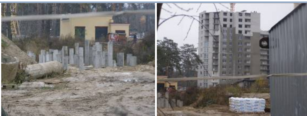
Рисунок Ошибка! Текст указанного стиля в документе отсутствует..3. Будівництво житлового комплексу (II черга) по вул. Лобановського, 1 у с. Чайці Києво-Святошинського району Київської області станом на листопад 2010 року: будинки № 8 та 10 (зліва направо)
