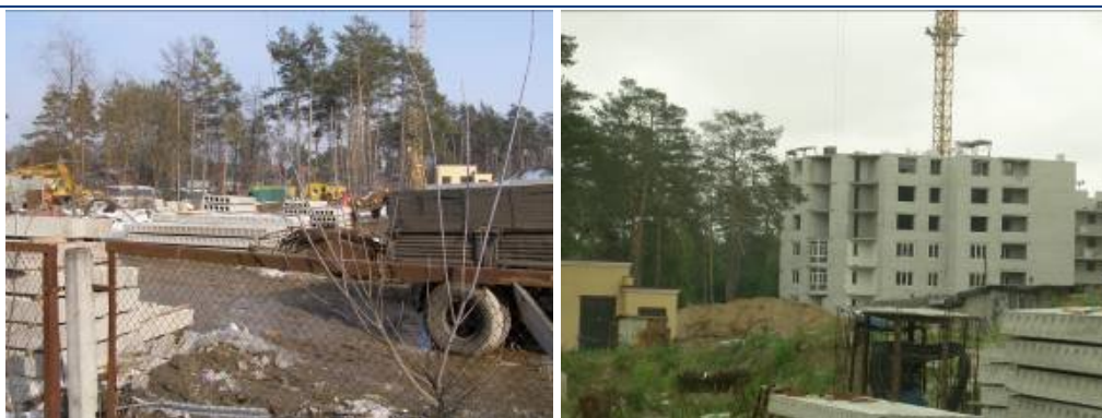
Рисунок Ошибка! Текст указанного стиля в документе отсутствует..2. Будівництво житлового комплексу (II черга) по вул. Лобановського, 1 у с. Чайці Києво-Святошинського району Київської області станом на березня та травень 2010 року
