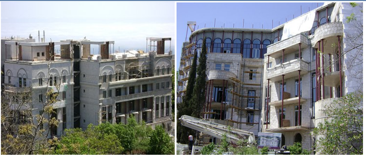
Стан будівництва житлового будинку по вул. Батуріна, 44А у смт. Лівадія м. Ялти станом на 06.05.2010 р.
