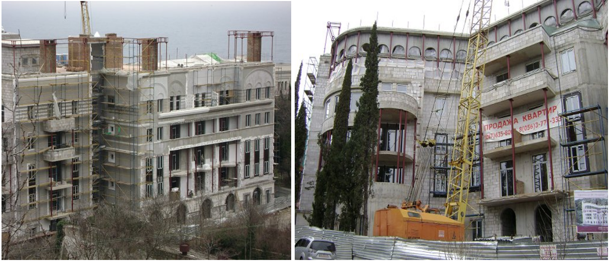
Стан будівництва житлового будинку по вул. Батуріна, 44А у смт. Лівадія м. Ялти станом на 04.03.2010 р.
