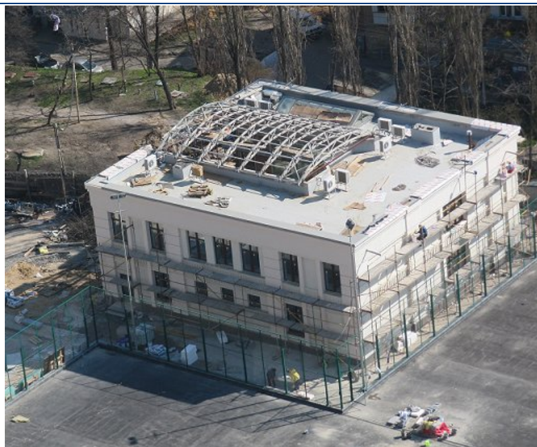
Хід будівництва спортивно-оздоровчої будівлі №21 (II черги житлового кварталу з об'єктами соціально-громадського призначення по вул. Професора Підвисоцького у Печерському районі м. Києва) станом на початок квітня 2012 року
