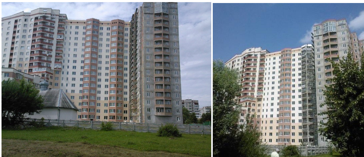
Хід будівництва багатопверхового житлового будинку з вбудованими офісними приміщеннями та підземними автостоянками по вул. Панча, 18-б у м. Львові станом на липень 2009 року
